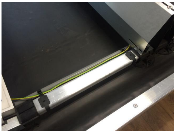
Figuur 9: Meeraderige kabel bevestigd met kabelclip
