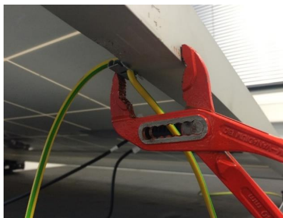
Figuur 6: Bevestigen van aardingsklem
